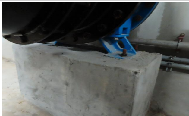
유출밸브실 배관 베드 상태양호
