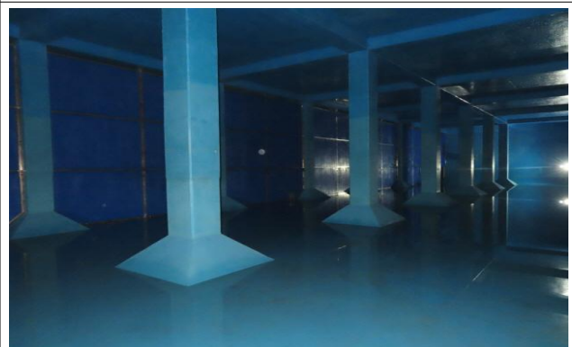
배수지 1지 내부 전경
