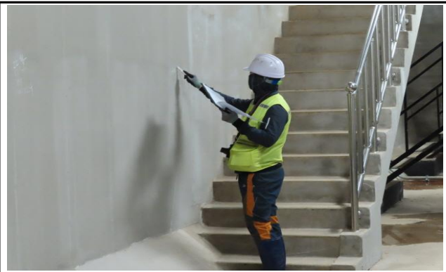
유·출입 밸브실 외관조사
