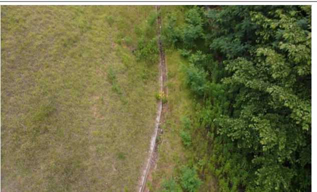
배수로 이물질퇴적 (남동측)
