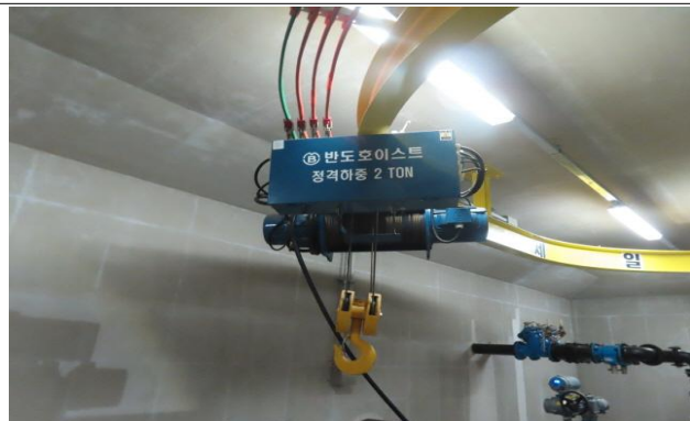
유입밸브실 호이스트 상태양호
