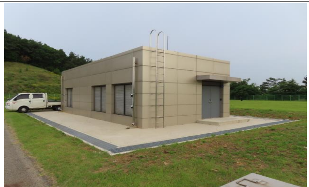
건축구조물 외부 사다리 상태양호
