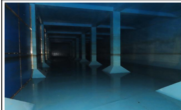
배수지 1지 내부 전경
